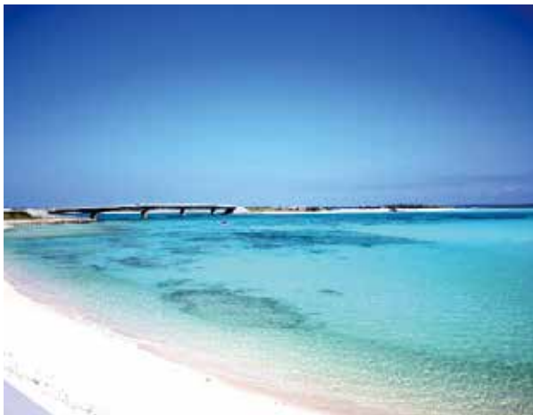
▲野浦大橋（伊平屋島と野甫島の間にかかる橋）
