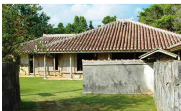
1977年に国指定重要文化財(建造物)に指定された「銘苅家住宅」 (▲いげな島観光協会ホームページより)
