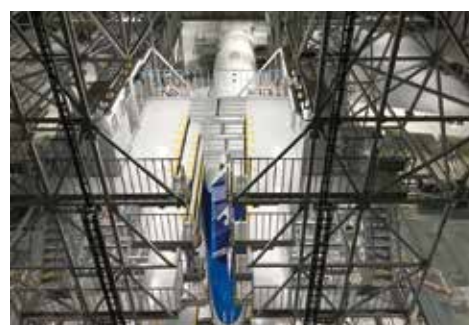
▲足場が組まれたANAの767
